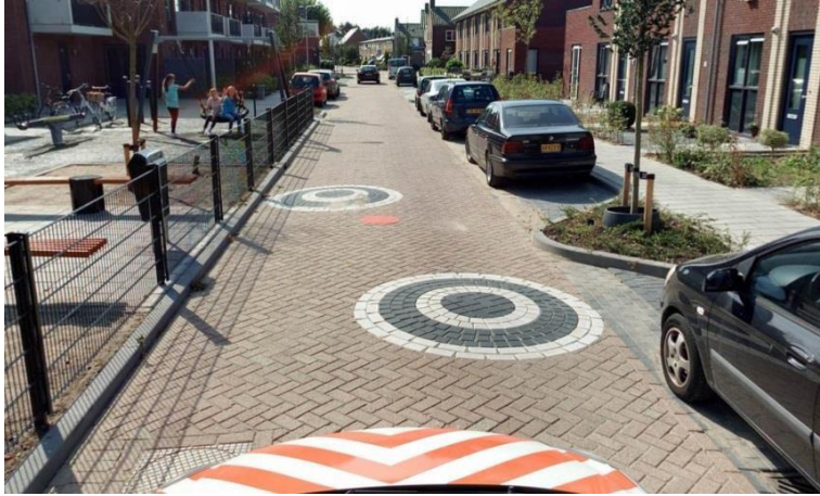
Mini punaises Een cirkelvormige verkeersdrempel
